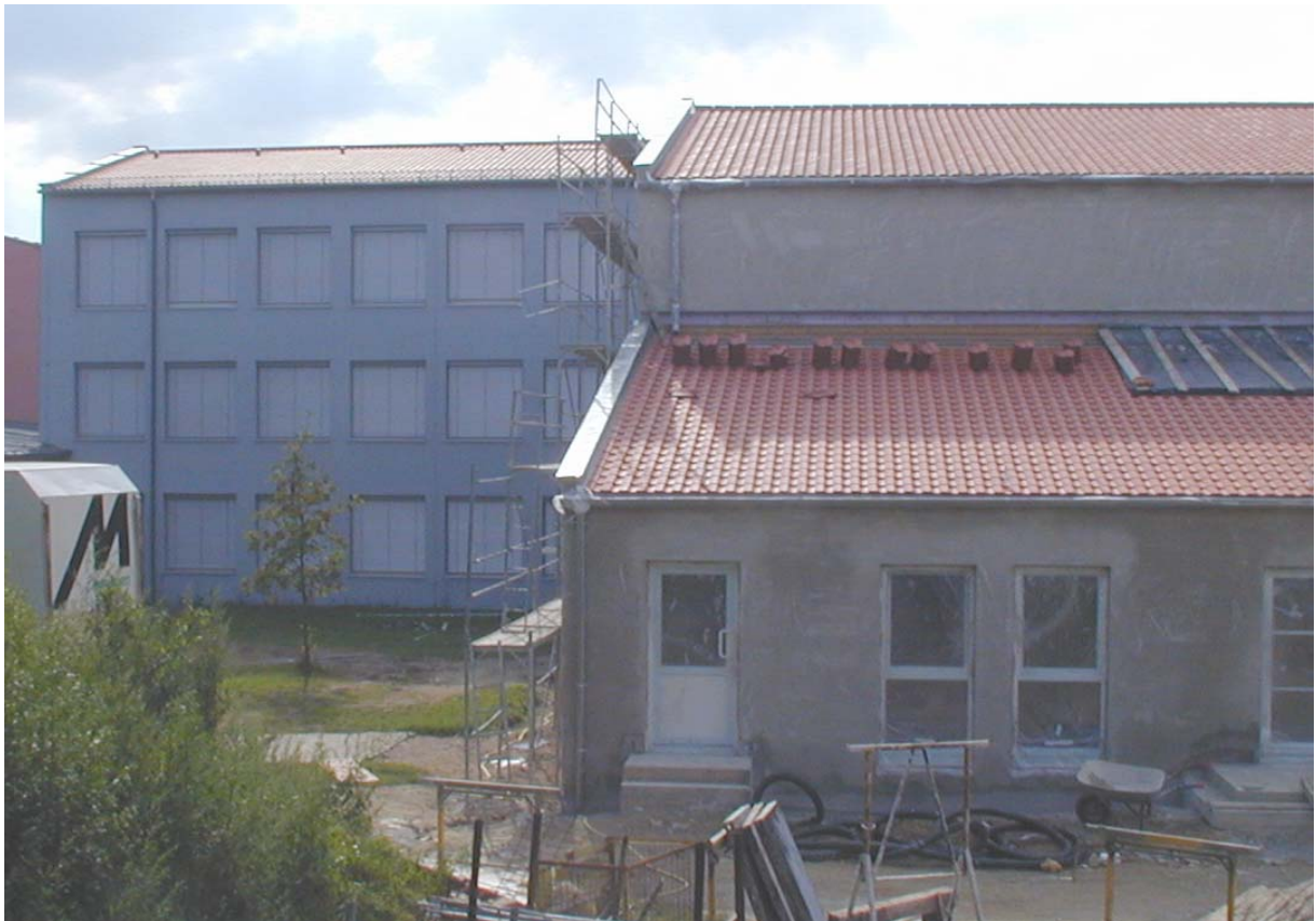
Turnhalle mit Anbau und Abschnitt D (Osten)
